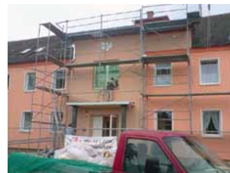
Die Wohnstätte „Friedrich Fröbel“ im Umbau
